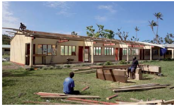
Práce na střeše tříd.
