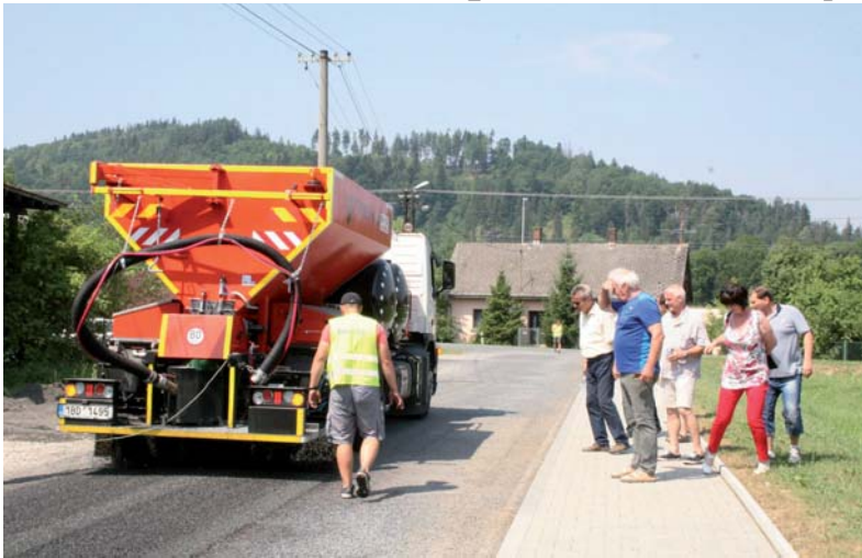
Starostové se zájmem sledovali opravu části silnice u Kravína.
