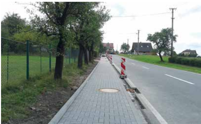
Výstavba nového chodníku u mateřské školy.
