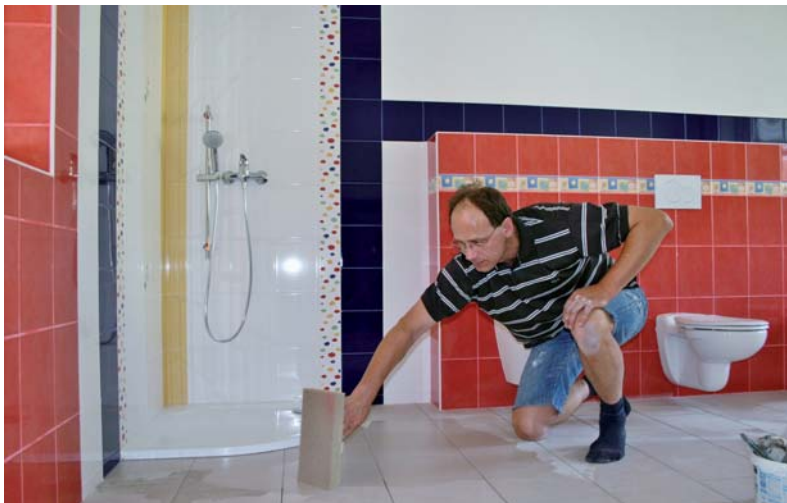
Učitel Miroslav Klimánek dokončuje rekonstrukci sociálního zařízení v mateřské škole.
