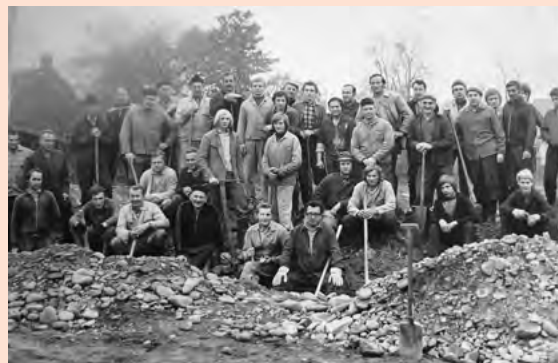
Archivní snímek z 10. září 1977 zachycuje více než tři desítky baštanských občanů, kteří se zúčastnili prvních výkopových prací pro stavbu nové mateřské školy v Bašce.
