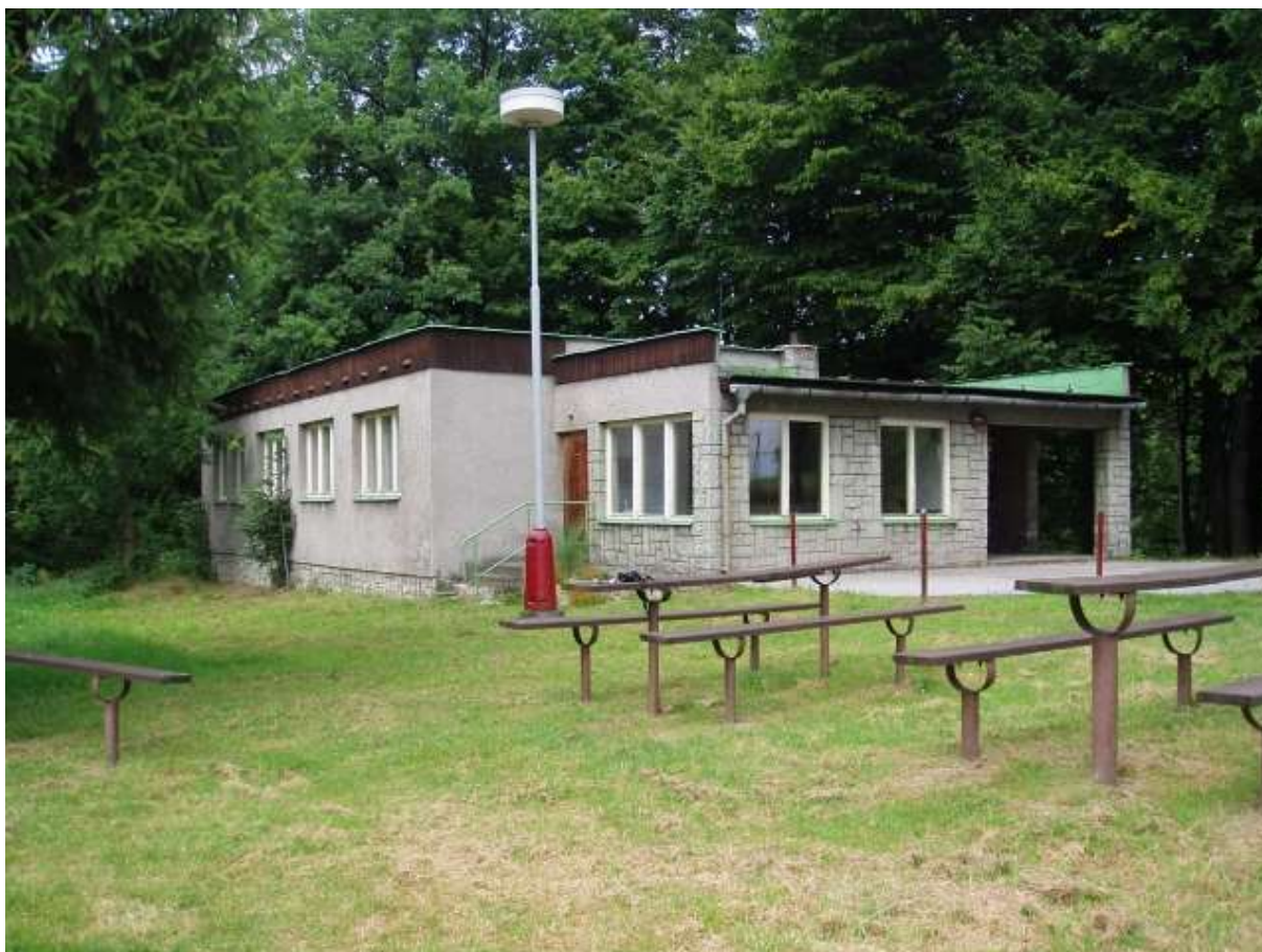
Sportoviště Kuřín před rekonstrukcí
